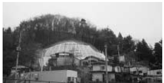
完成した急傾斜地対策工事
